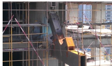
图7端部下弦杆固定
