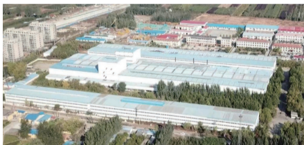
河北中钢钢铁有限公司厂房项目
